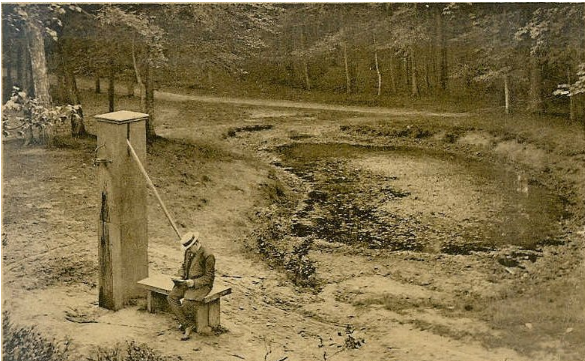
"De Pomphul" van Hoog Soeren waarschijnlijk rond 1918.
