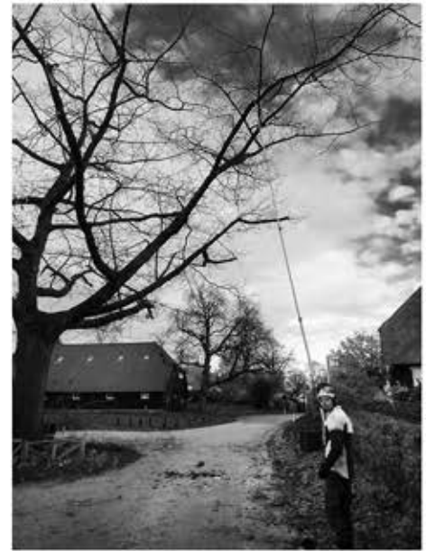
De sloop begonnen
